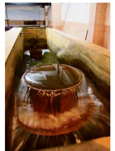
Vandens priėmimo kamerą vanduo patenka iš gręžinių/Laimos Rekevičienės nuotrauka
