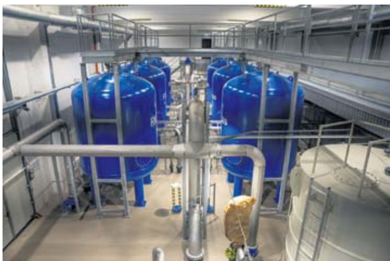
UAB „Druskininkų vandenys“ įgyvendinus nuo 2018 m. vykdytą projektą, atlikta vandens gerinimo įrenginių, esančių M. K. Čiurlionio g., rekonstrukcija ir įrengti nauji uždaro tipo vandens nugeležinimo filtrai / Edgardo Tamkevičiaus nuotraukos
