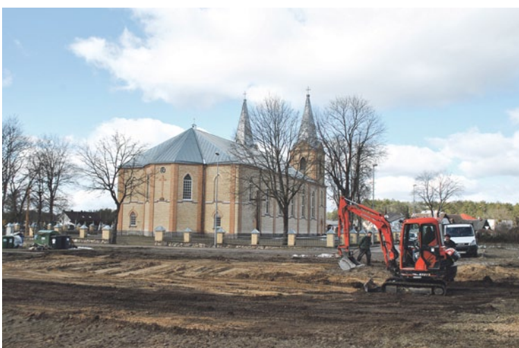
Paslaugų ūkio darbuotojai nugriovė prie Ratnyčios bažnyčios stovėjusį nenaudojamą ūkinį pastatą – jo vietoje atsiras dar viena erdvė „Džiugučių“ laisvalaikui/Laimos Rekevičienės nuotrauka
