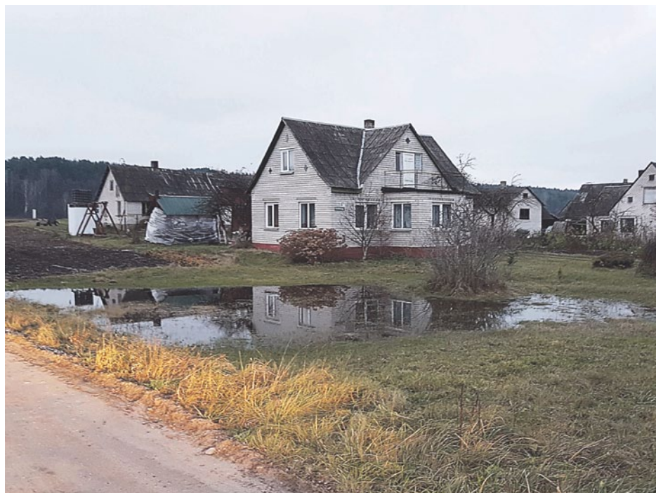
Dar sovietmečiu įrengta melioracijos sistema užakusi, susidėvėjusi, nebeatlaiko didesnių liūčių – dėl to užliejami gyventojų kiemai, rūšiai, užteršiami šuliniai, neretai prireikia ugniagesių pagalbos, išpumpuojant vandenį/ Savivaldybės archyvo nuotrauka
