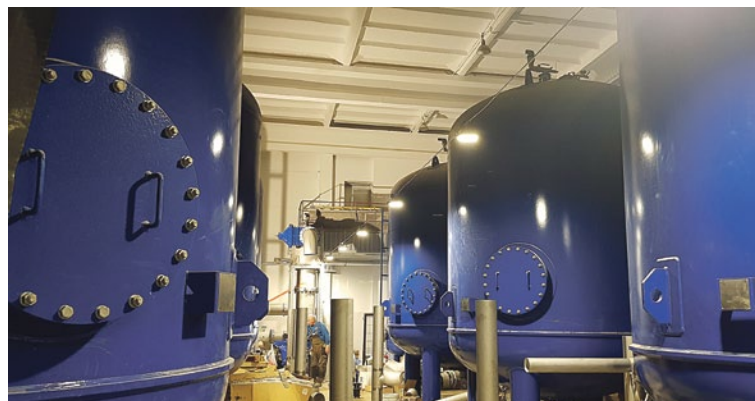
Montuojami nauji vandens filtrai/Laimos Rekevičienės nuotrauka
