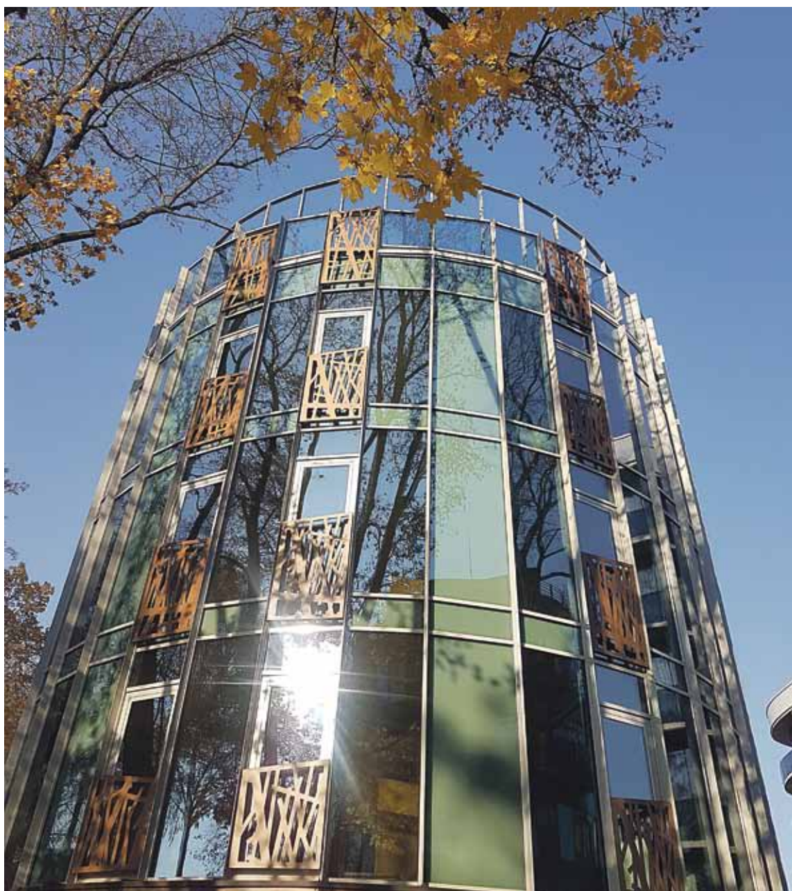
Vila „Sol“ išskirtine fasado apdaila papuošė kurorto centrą
