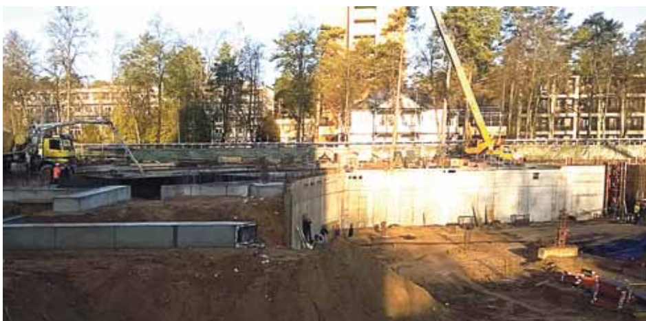
Sėkmingai vykdomi požeminių laiptų žemės darbai, rūšio sienų betonavimas, ruošiamasi metalinių sijų montavimui/Druskininkų savivaldybės archyvo nuotrauka
