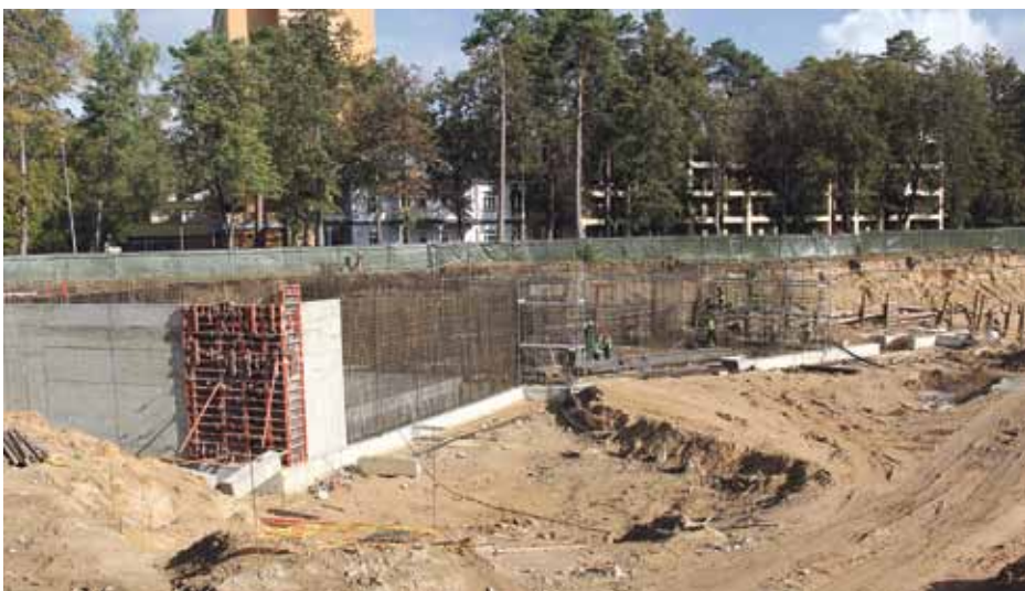
Būsimojo kultūros centro statybvietėje virte verda darbas – tvirtinami statybų duobės kraštai, pradėti pamatų liejimo darbai/Laimučio Genio nuotrauka
