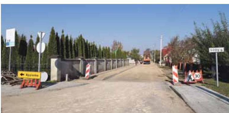
Gatvių asfaltavimo darbai įsibėgėjo Leipalingio miestelyje/Dianos Sinkevičiūtės nuotrauka
